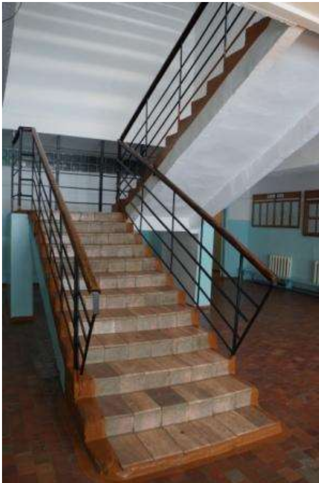
Фото № 8. Лестница (внутри здания)
