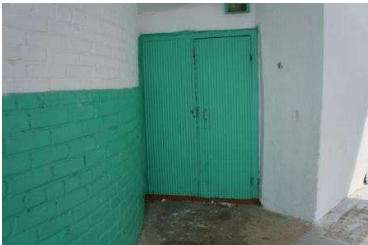
Фото № 4. Дверь входная.
