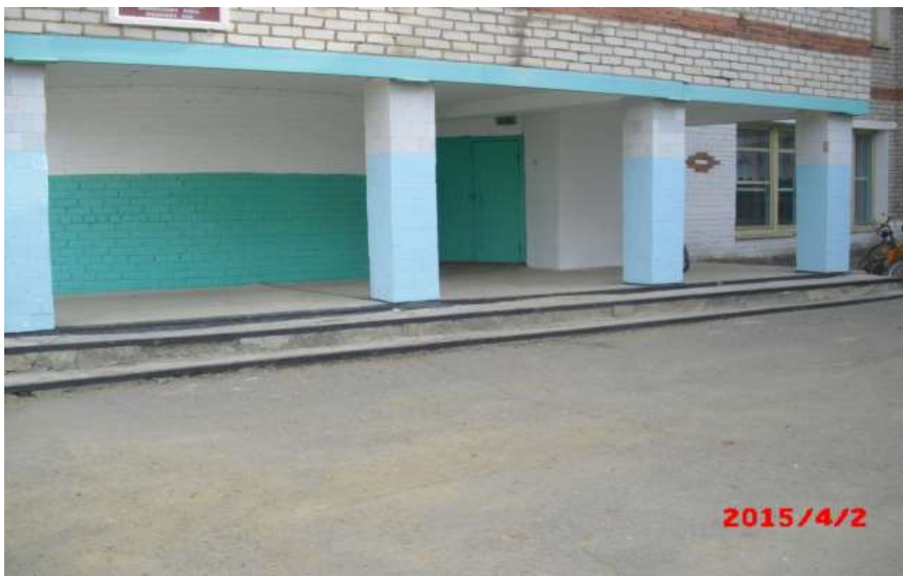
Фото № 3 Входная площадка.
