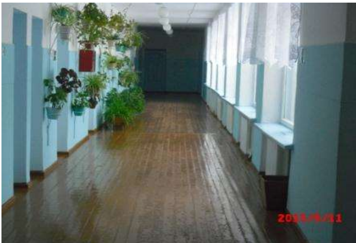
Фото № 10. Коридор 2 этаж. Пути эвакуации.
