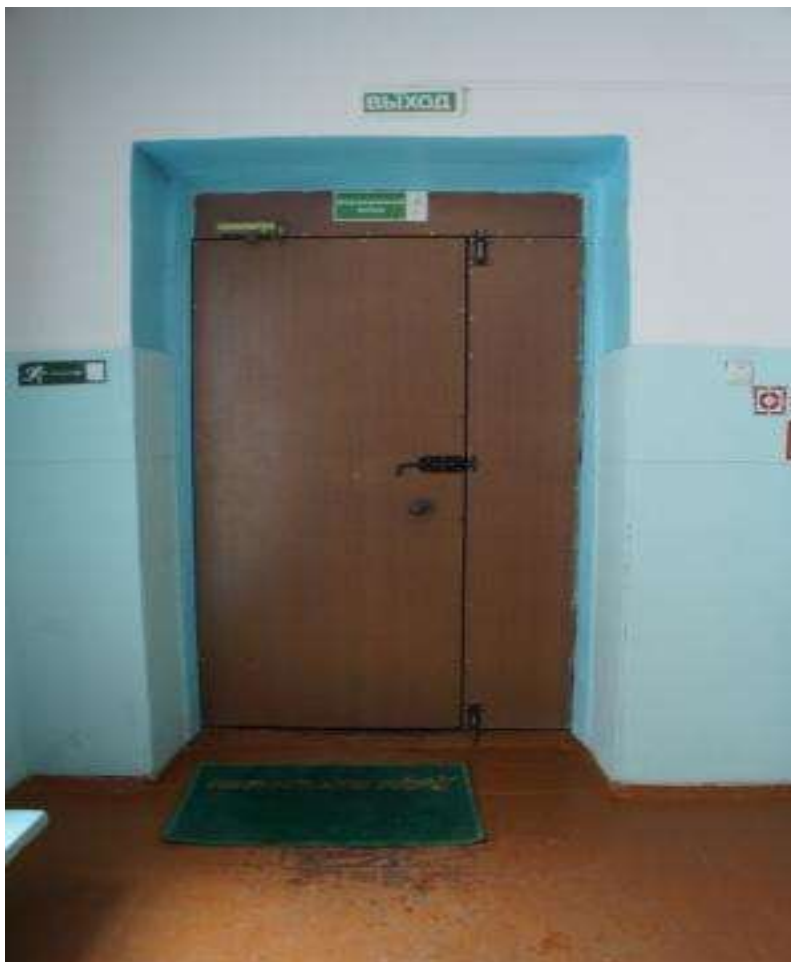
Фото № 9. Дверь входная (внутри здания).
