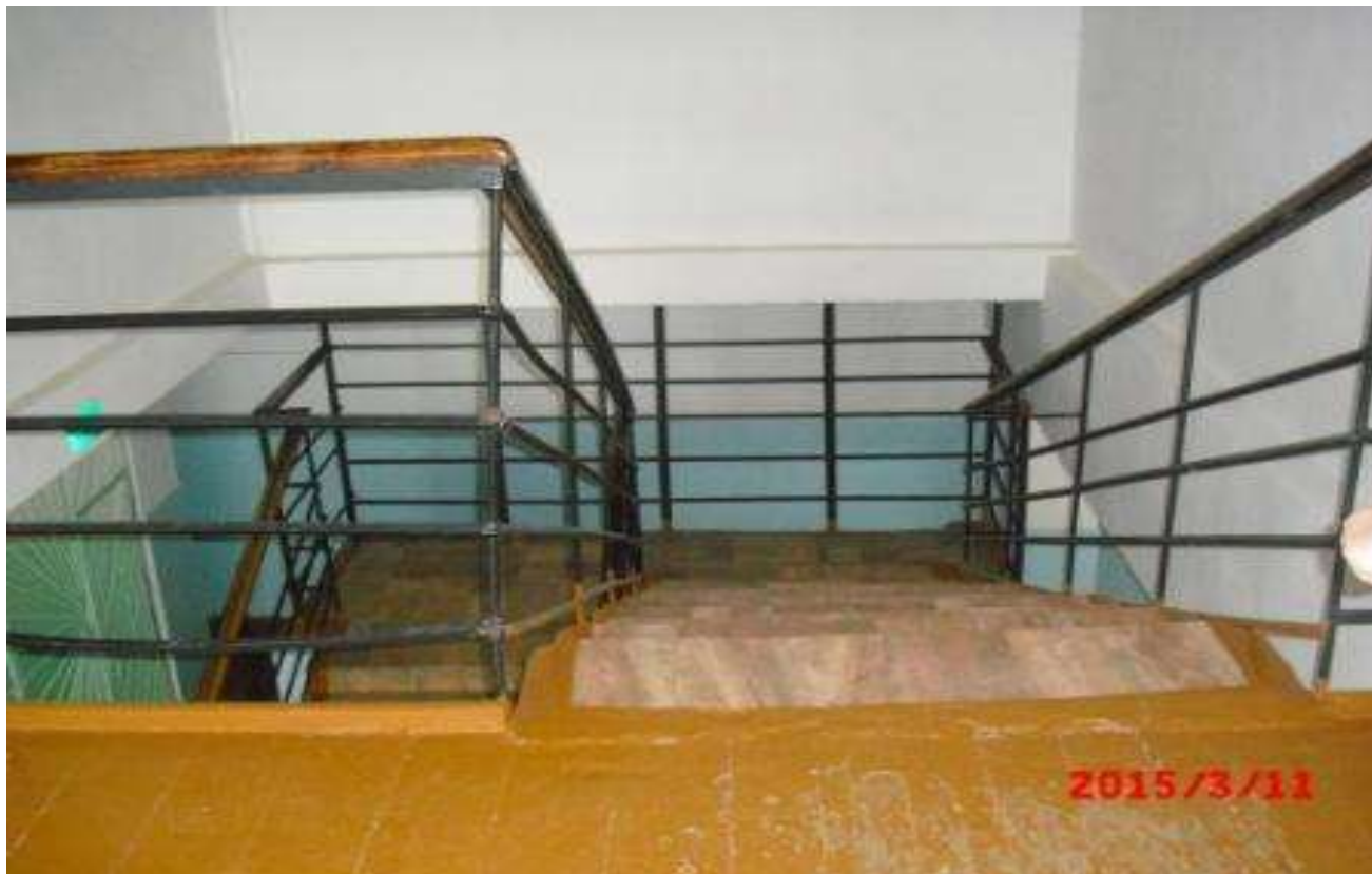
Фото № 11. Лестница. Пути эвакуации.
