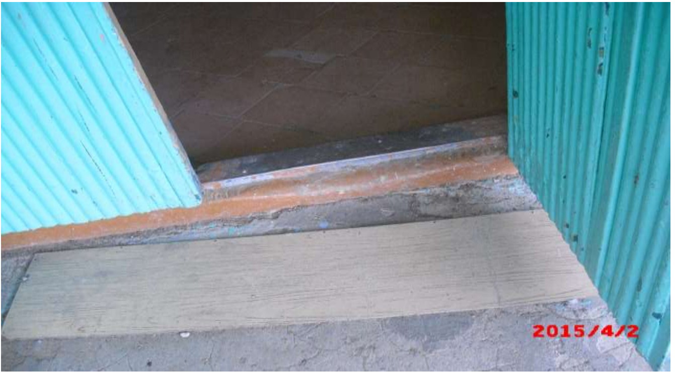
Фото № 5. Порог входной двери.
